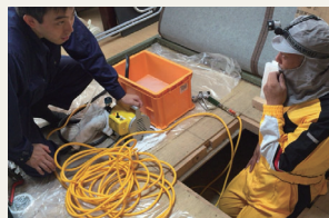
シロアリ予防・駆除工事の様子
