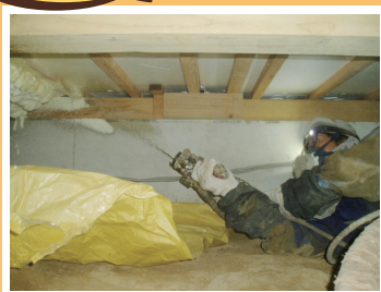
床下での断熱材設置作業の様子
