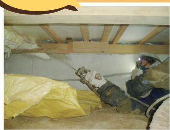
床下での断熱材設置作業の様子
