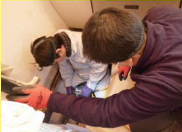
シロアリ予防・ 駆除工事の様子
